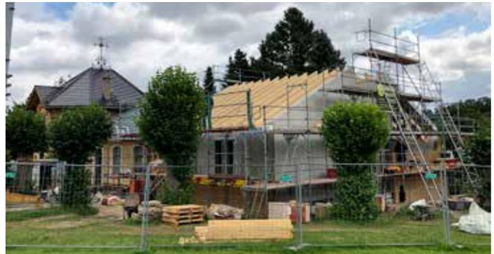
Der Dachstuhl für die zwei Haupt-Pultdächer des Neubaus wird montiert. Parallel laufen die Fassadenarbeiten.
