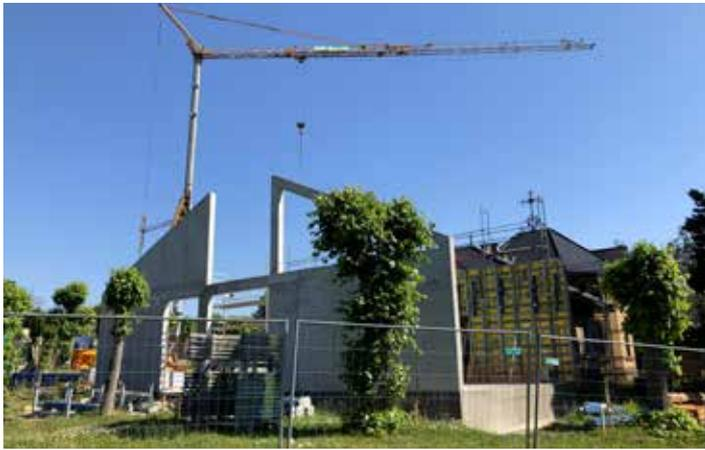
Die Stahlbetoninnenschale der Wand 3 ist fertig ausgeschalt, die Schalung für die Wand 1 bindet direkt den Bestandsbau mit ein.
