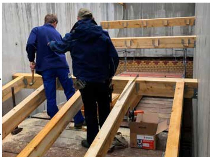
Während bei den beiden Hauptpultdächern die Dachdecker- und Klempnerarbeiten beginnen, wird das kleine Zwischen-Pultdach durch die Zimmerer eingebaut
