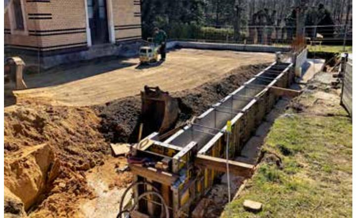
Schalungsarbeiten für die Frostschräge im nördlichen Teil des Neubaus und Auffüllung innerhalb der Fundamente
