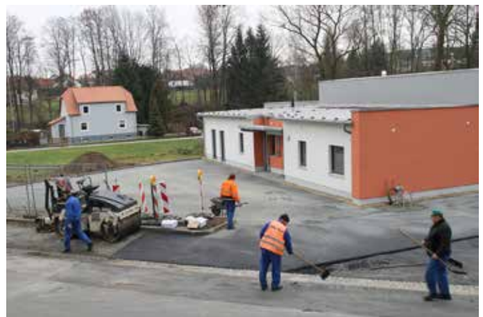
Letzte Handgriffe vor der Fertigstellung
